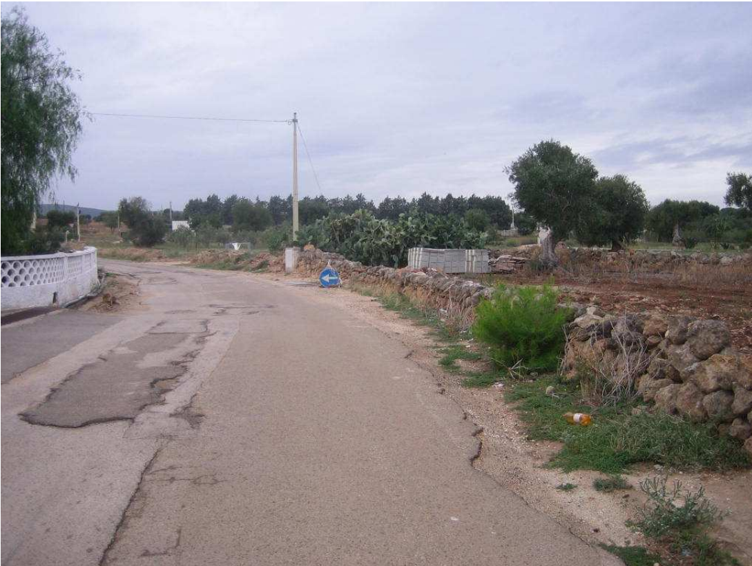
Figura 4 - Vista del fronte strada
