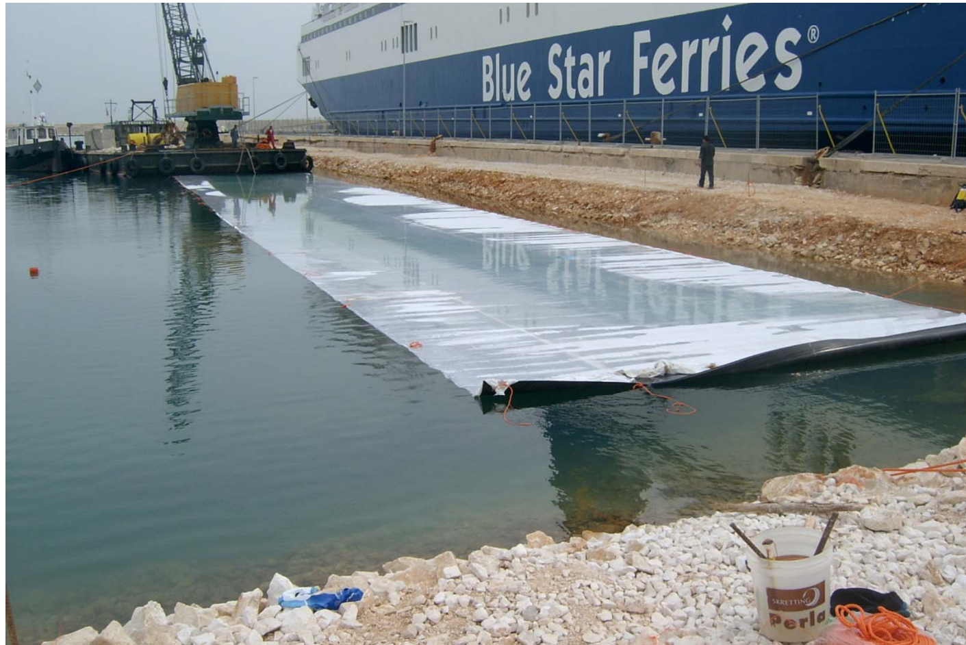
Posa del telo impermeabilizzante - Porto di Bari (Darsena di ponente)
